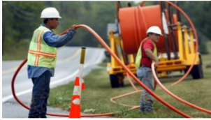
Pembangunan proyek 4G telkom pemasangan kabel fiber optik
